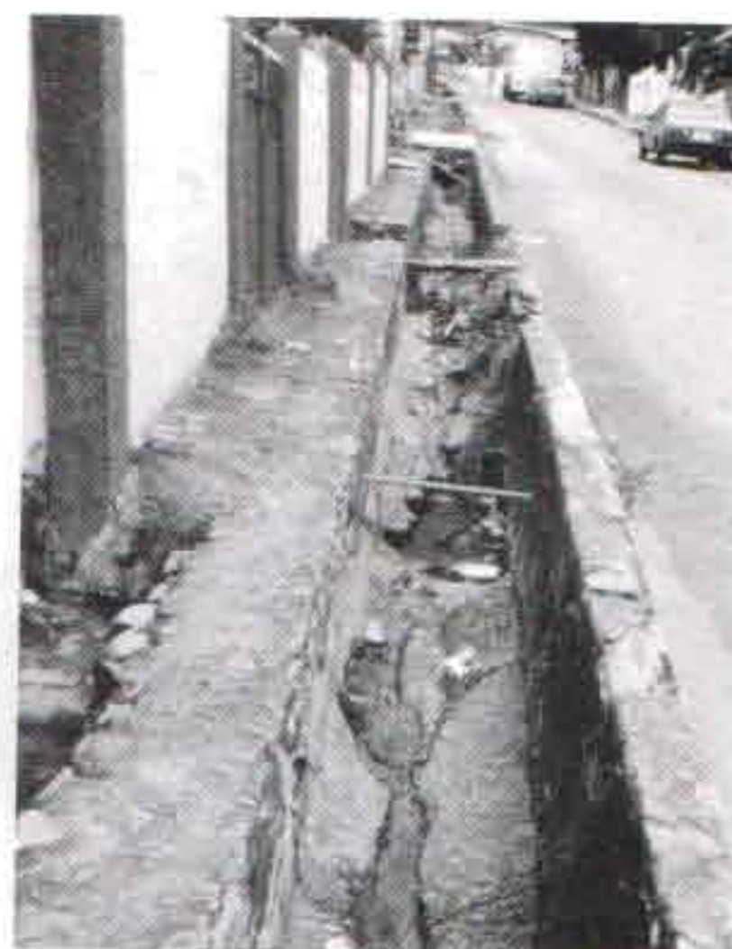
5. Égout à ciel ouvert
